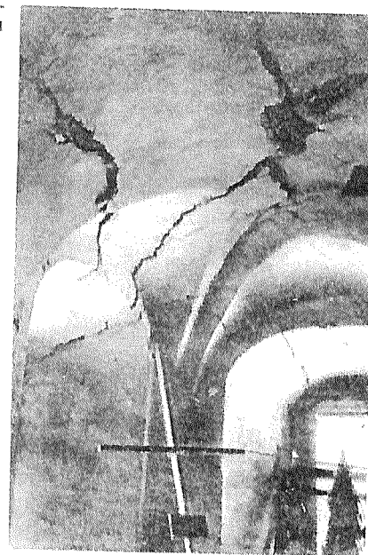
Рис. 48. Деформации крестовых сводов при расползании опор
