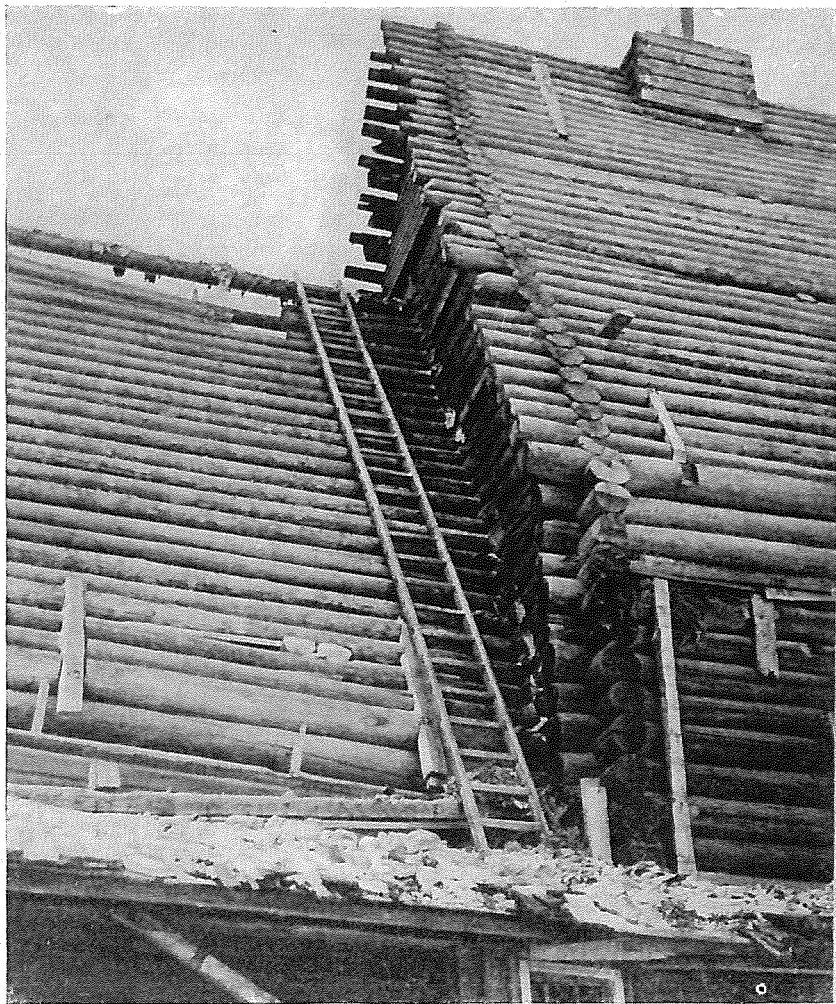
Рис. 5. Кровля молельни Спасо-Преображенской церкви в процессе разборки
