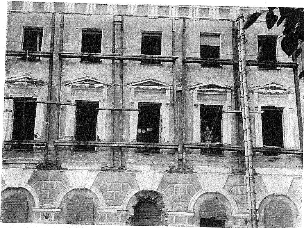
Рис. 3. Металлическая рама, поставленная на гласный фасад здания бывших Наследских казарм
